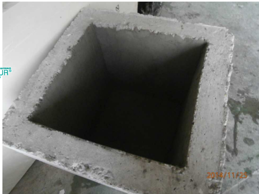
Detalle de la impermeabilización de uno de los depósitos.
