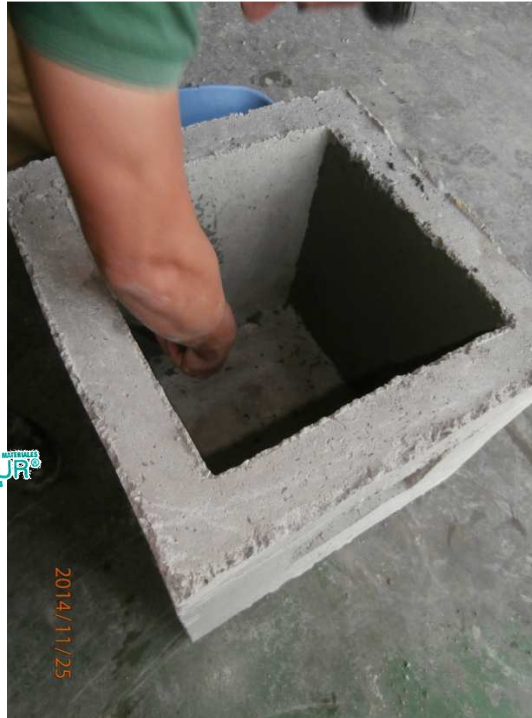
Detalle de la aplicación de la capa del mortero impermeabilizante.
