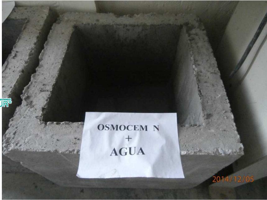
Depósito impermeabilizado con el sistema I: Osmocem N+Agua potable.
