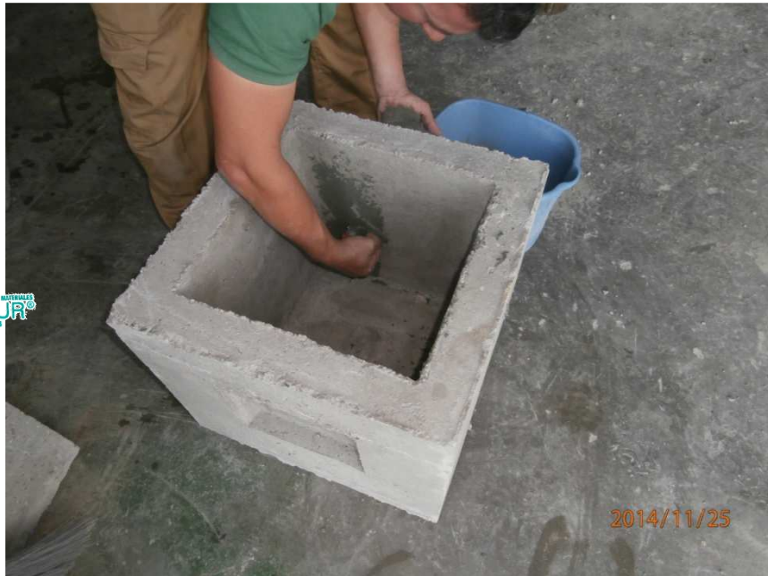
Detalle de la aplicación de la capa del mortero impermeabilizante.
